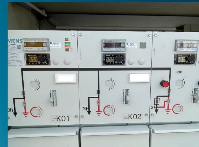
ComPass D von Horstmann in den Mittelspannungsfeldern
