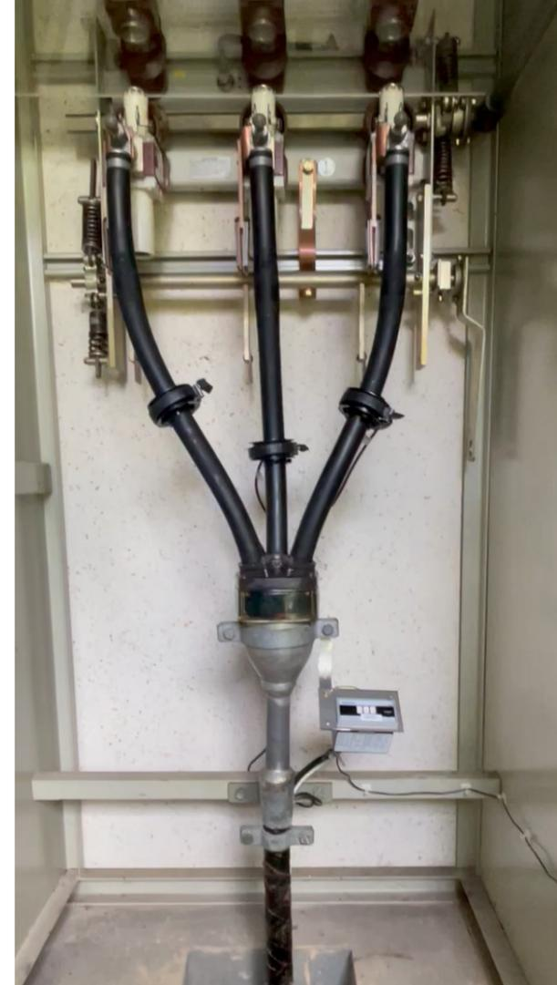
Der typgeprüfte Aufbau bestehend aus Sensor und Halterung erlaubt einen teilentladungsfreien Betrieb für Nennspannungen bis 11kV.
